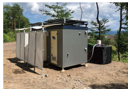
長野県 [工事現場 /WII型]
