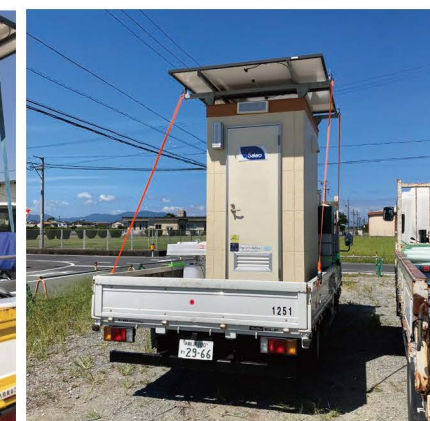
堤防整備工事
