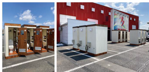
パチンコ店トイレ改装工事現場
