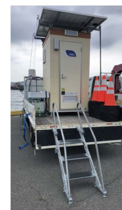
防波堤改良工事
